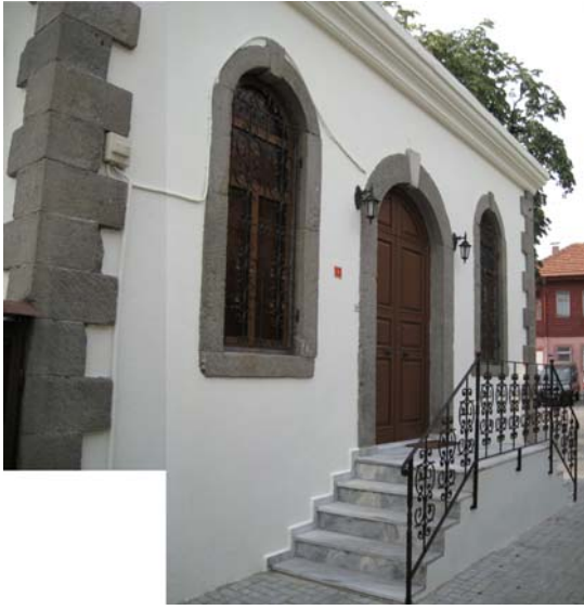
Şekil 16. Bartın Amasra, Hükümet Dairesi giriş (Doğu) cephesi (Topçubaşı, 2007)
