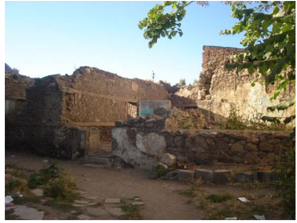
d) Yıkılmış ev örneği
