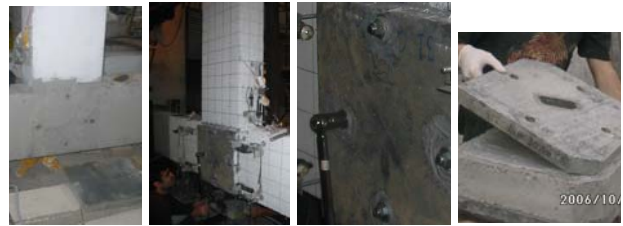
Şekil 13. HPFRCC paneller ile güçlendirme uygulamaları
